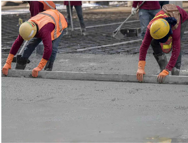
Most Debrecenben építhet utat a Duna Aszfalt
